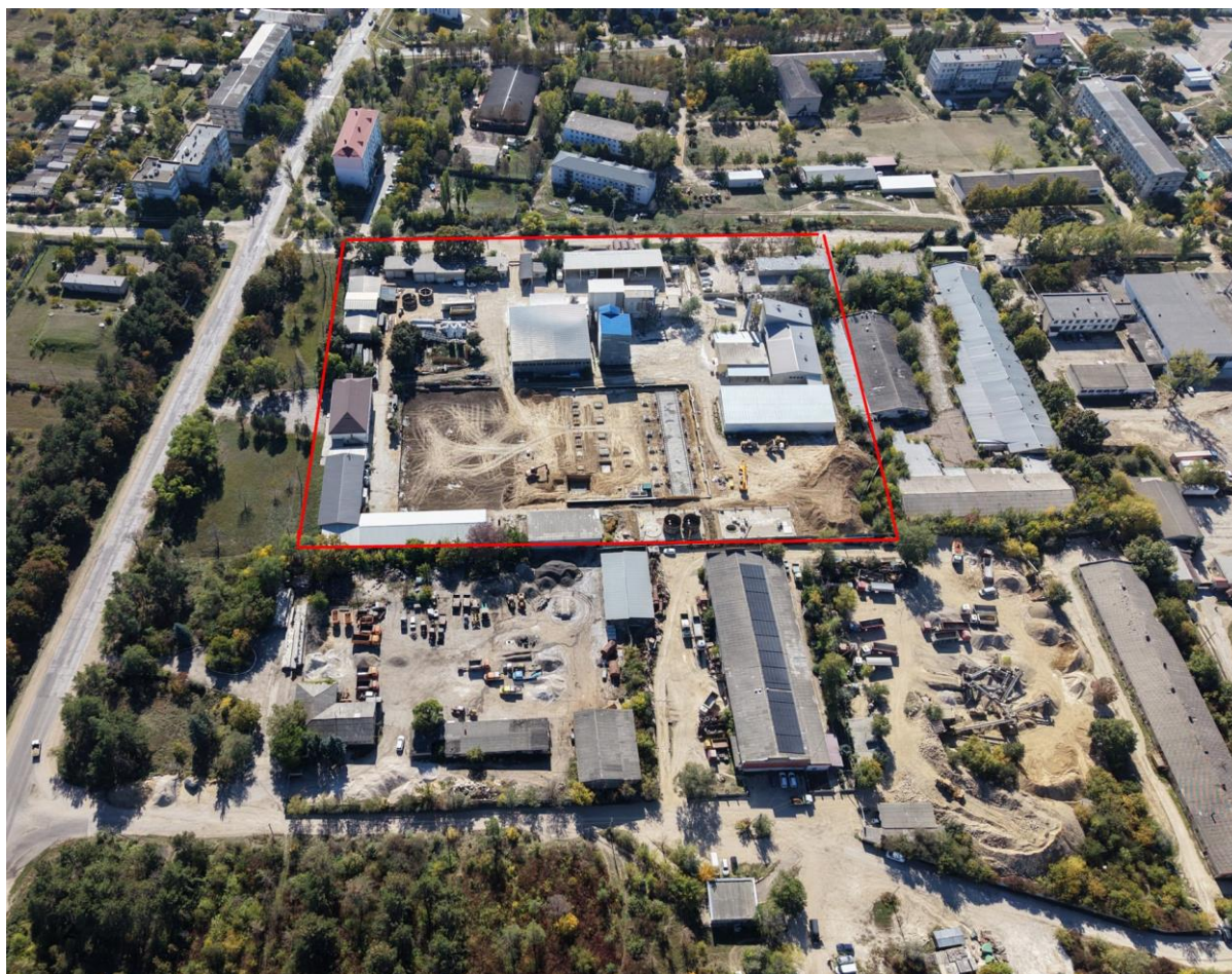
Foto 1. Platforma GENERAL BUILDING din or. Florești, str. Mihai Viteazul 31 (nr. cad. 4501212.180) – vedere de sus; limita terenului marcată cu linie roșie. Se observă lucrări noi de construcție.
